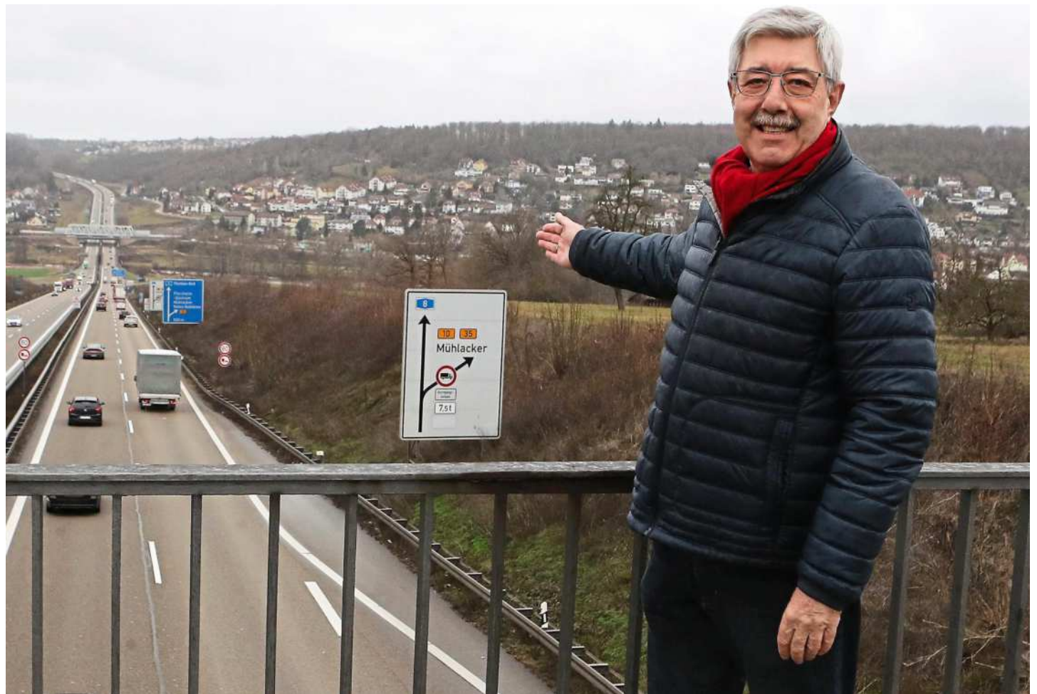
Hofft auf eine anwohnerfreundliche Umsetzung: Bernd Schuster vor dem Beginn der Bauarbeiten auf der Brücke an der Raststätte Pforzheim. Foto: Harry Rubner
