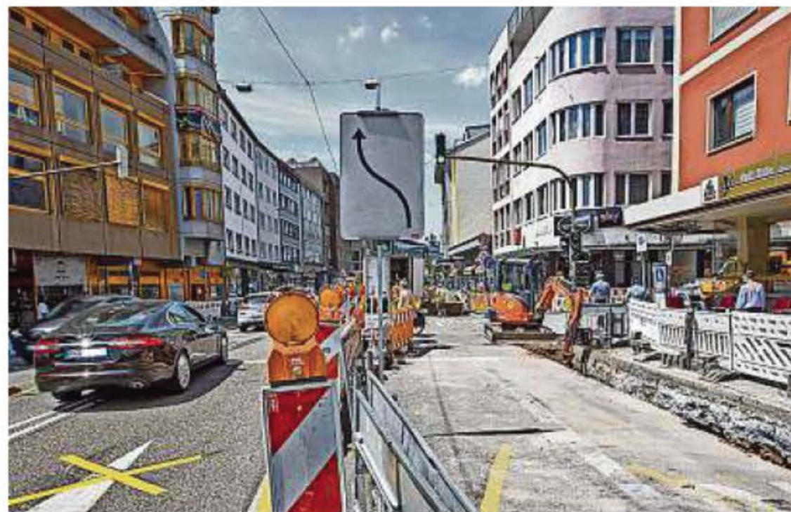
Wochenlang sorgten Baustellen wie die auf der Zerrennerstraße für zusätzliche Staus in der Innenstadt.
