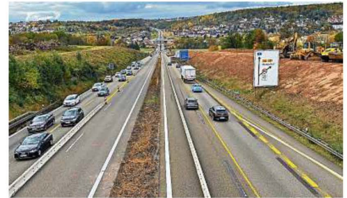
Wahrscheinliche Ursache: Für erste Ausbauarbeiten im Enztal sind gelb markierte Spuren eingerichtet – nicht weniger als bisher, aber schmaler.
