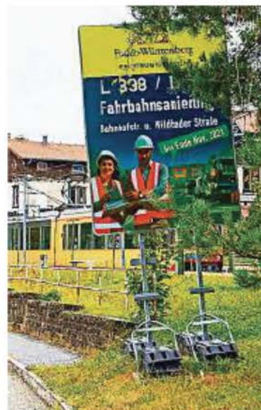
Mindestens bis Ende November bleibt der Neuenbürger Ortskern Baustelle.
