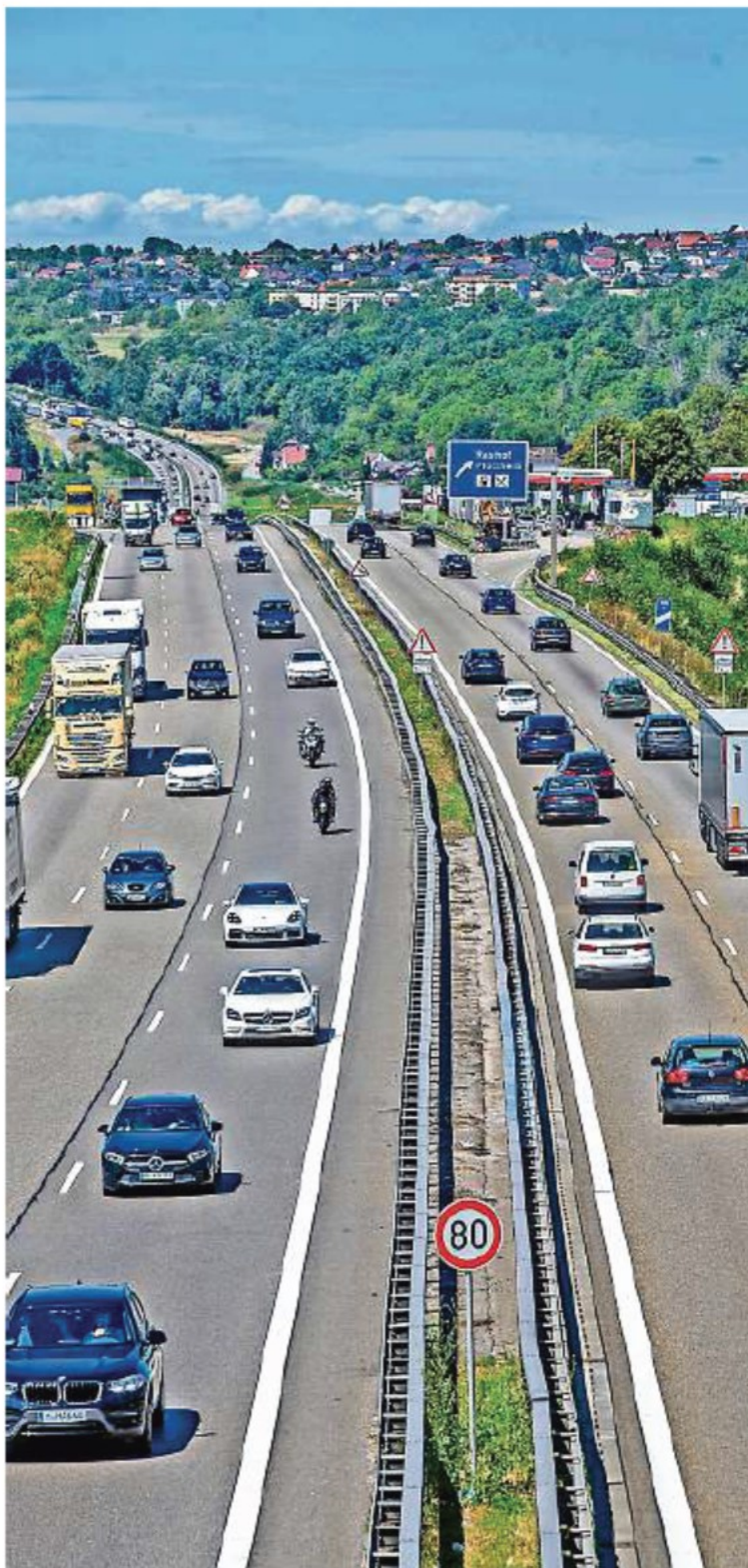
Dass sich der sechsspurige Ausbau der A8-Enztalquerung verzögert, könnte noch eine ganze Reihe anderer Probleme nach sich ziehen. FOTO: MEYER
