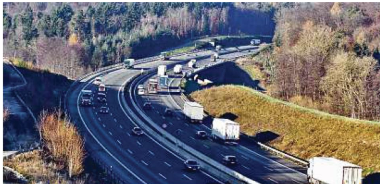
Problembereich in Sachen Lärmschutz ist die rund 180 Meter lange Bockbachtalbrücke in der Senke bei Mutschelbach. Hier wird eine Lärmschutzwand gefordert. Ebenso die Verlängerung der Erdwälle bis zur Brücke.
